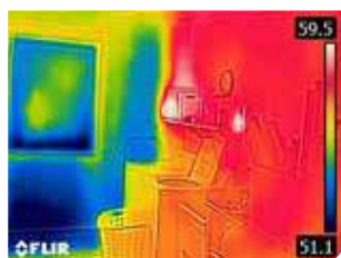
Parete esterna non isolata
