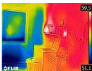
Parete esterna non isolata
